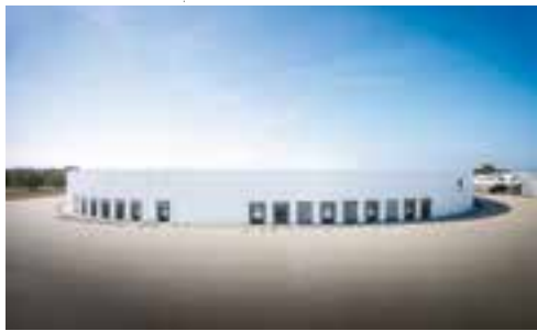
Fabrikhalle Vitra in Weil am Rhein von SANAA
