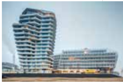
Marco-Polo-Tower und Unilever-Haus in Hamburg von Behnisch Architekten
